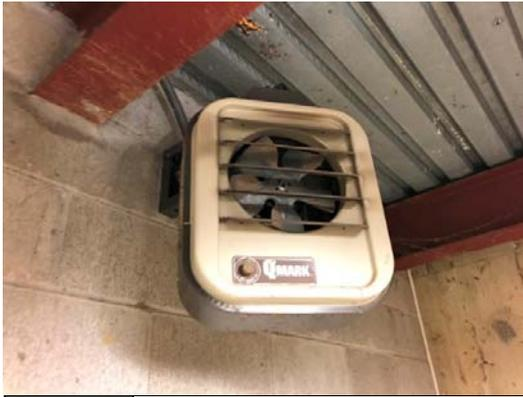
PHOTO #19: SUSPENDED UNIT HEATERS
