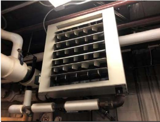
PHOTO #19: SUSPENDED UNIT HEATER
