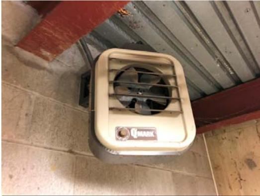
PHOTO #19: SUSPENDED UNIT HEATERS
